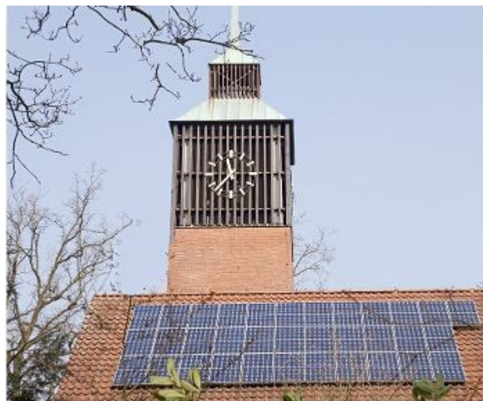
Solarzellen auf Gotteshäusern - wie hier auf der Fredenbecker Martin- Luther-Kirche – sind die Ausnahme. Fotos: Schmidt
