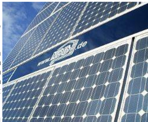
Bietet Service und Innovation: NDB setzt immer auf die neuesten Trend wie etwa Photovoltaikanlage.
