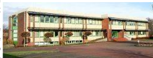
Die Stader NDB-Zentrale entstand im Jahr 1985 im Gewerbegebiet.
