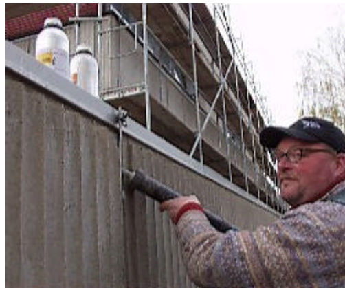
Dämmt: Markus Otto von NDB-Bautechnik aus Stade dichtet die alte Betonfassade des Schulzentrums Altes Land in Jork ab. Foto: Vasel
