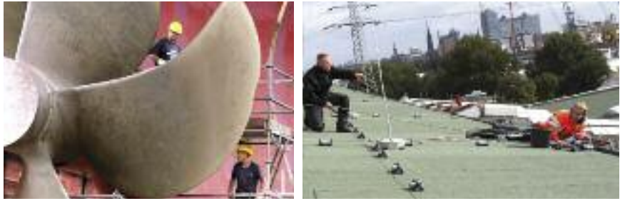
Fertigstellung – schneller als der Blitz
