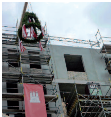
Baustelle mit Format
